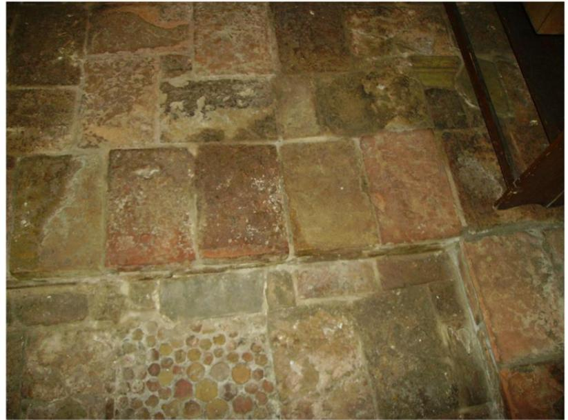
Fig. 8 Fotografia di una porzione di pavimentazione: si noti la varietà dei materiali usati.
