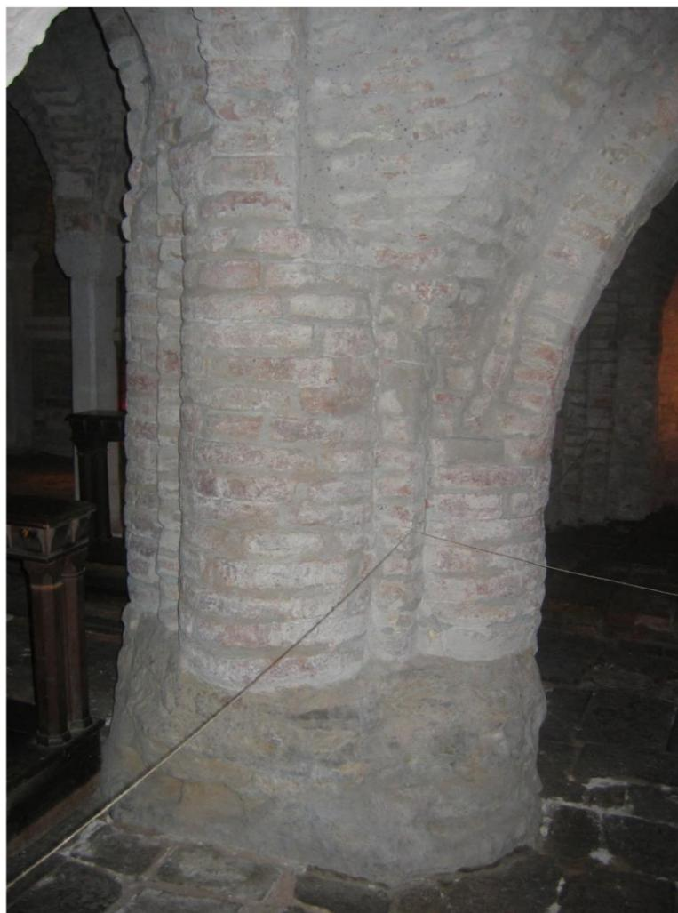
Fig. 6 Fotografia di un pilastro polilobato: si noti come l'attacco delle volte a crociera sia profondamente ammorsato all'interno del pilastro.
