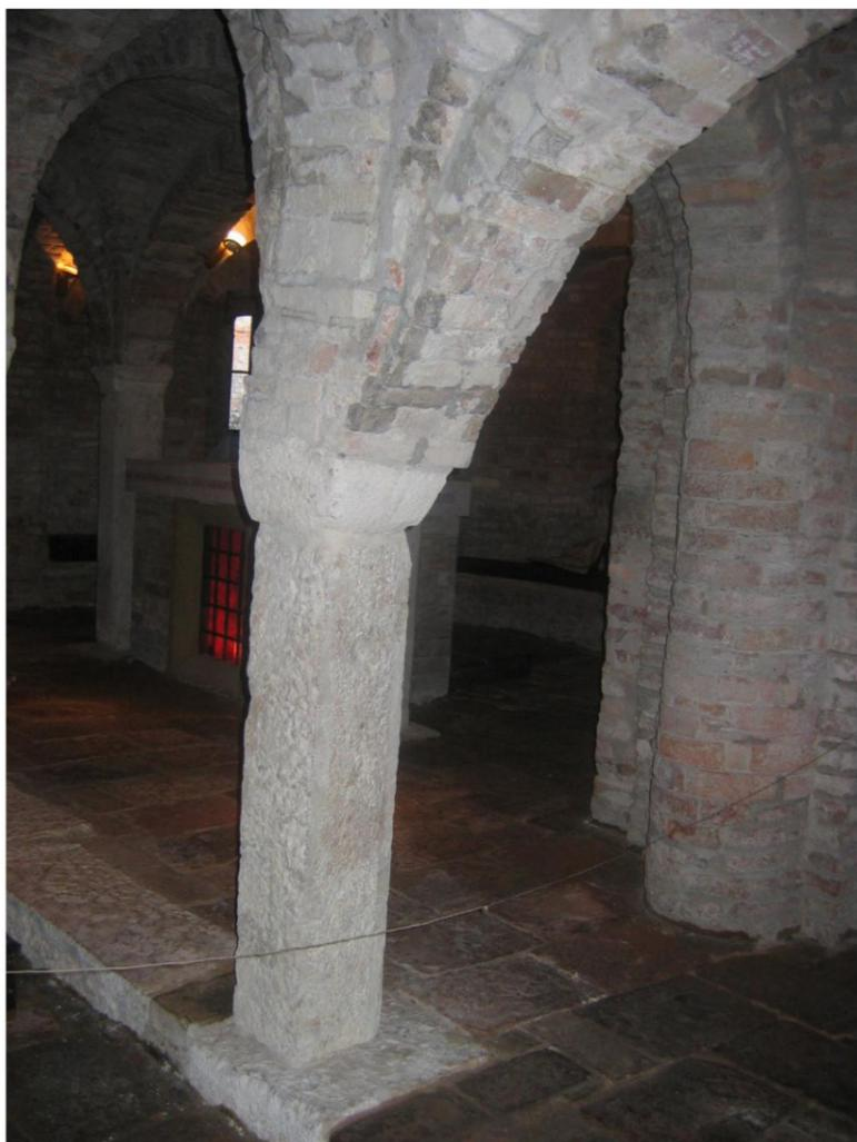
Fig. 5 Fotografia di una colonnina: si noti l'evidente utilizzo di materiali di riuso.
