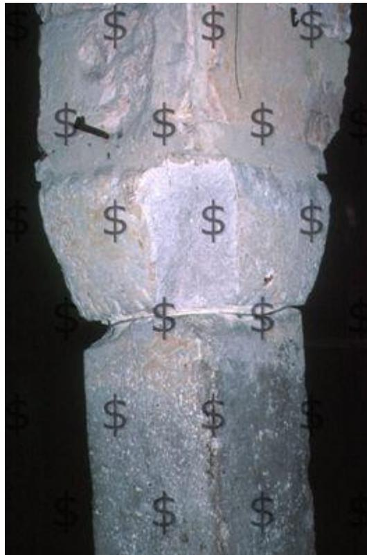
Fig. 9 - Uno dei capitelli delle dodici colonnine, in calcarenite (9 in fig. 7) presenta, come mostra la foto qui riprodotta, una preoccupante spaccatura da compressione. La sottostante colonnina a sua volta esibisce una notevole pendenza
