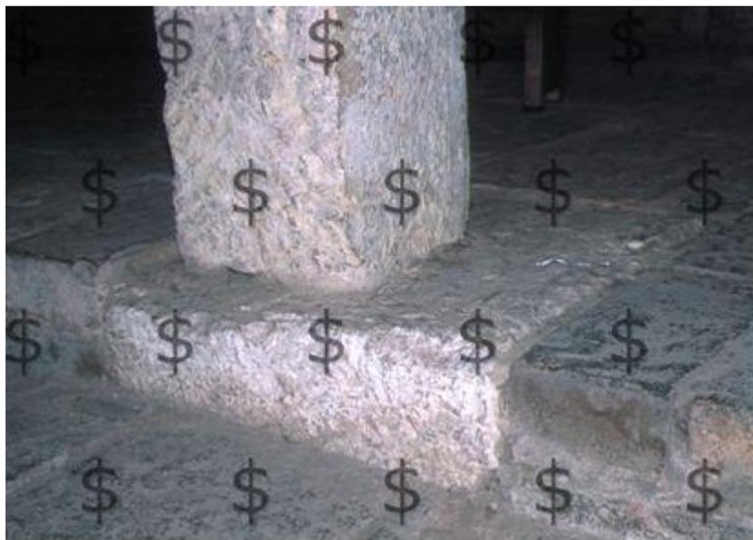
Fig. 11 - Se si osserva questa foto si può notare come il blocco prismatico in calcare che fa da plinto alla colonnina (7 in fig.7) si sia sollevato a destra e si è abbassato a sinistra. Ciò è dovuto al fatto che la colonnina non poggia al centro del masso (vale a dire all'incrocio delle diagonali) e quindi questo "ha fatto barchetta" immergendosi nella direzione dove il carico è maggiore e innalzandosi nella direzione opposta.
