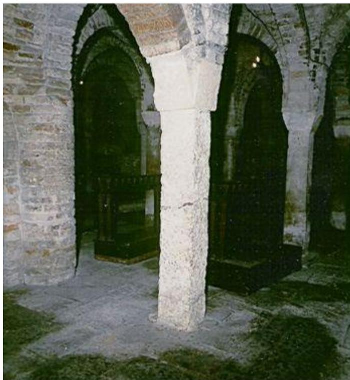
Fig. 8 - La colonnina nella foto (la 4 in Fig. 7) si ruppe prima della messa in opera : i due tronconi vennero riutilizzati interponendo tra l'uno e l'altro una lastra di piombo (ben visibile a circa 80 cm dal pavimento). (foto Ferrieri).
