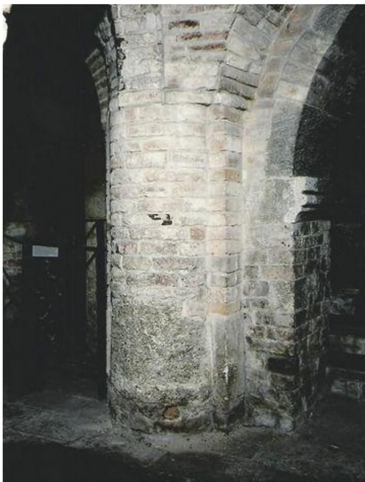
Fig. 18 - In uno dei lobi - quello ad est - di un pilastro cruciforme (2 in Fig. 7) è inserito un rocco in selenite di notevoli dimensioni : si tratta con ogni probabilità di un blocco un tempo di forma prismatica simile a quello di figura 25 e analogo ad altri rinvenuti in questo sito e appartenenti a un'antica costruzione, forse d'epoca romana, qui rielaborato in forma semicilindrica (Foto P. Ferrieri).
