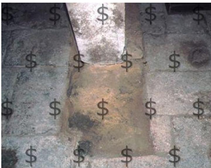
Fig. 10 - Se si osserva questa foto si può facilmente notare che il plinto in arenaria della colonnina (la 5 in fig. 7) fu adattato alla cavità ottenuta togliendo alcuni mattoni in cotto del pavimento : dunque il pavimento c'era già quando la colonnina venne messa in opera. Il pavimento infatti apparteneva a un monumento precedente (VIII secolo) e venne riutilizzato tal quale quando più tardi (XI secolo) si edificò la Cripta.
