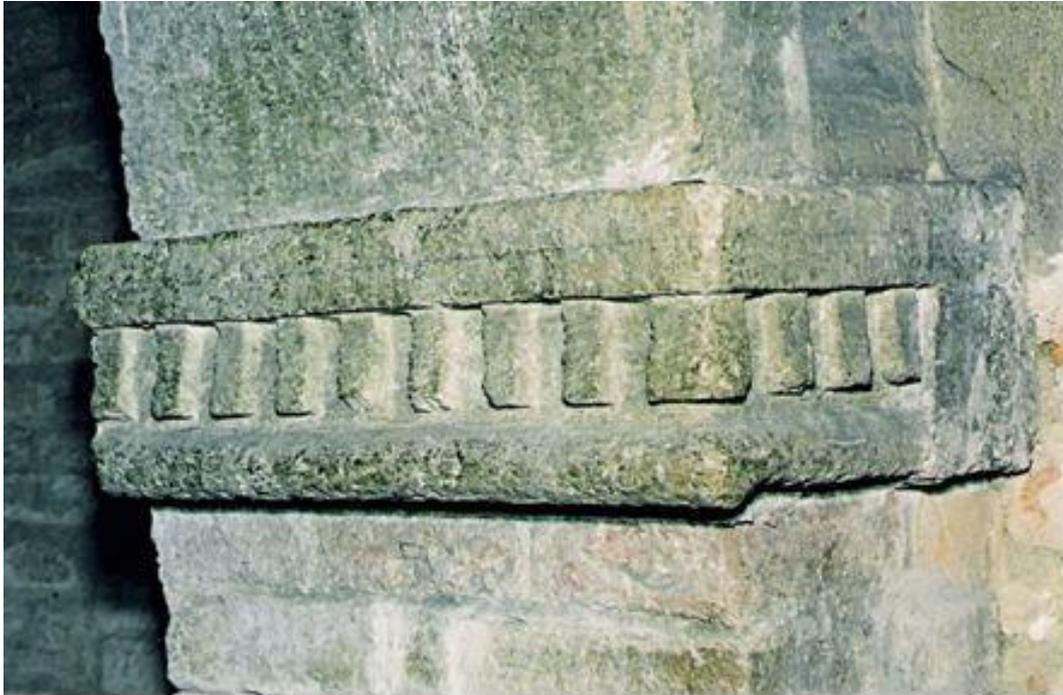
Fig. 5 - La selenite, assieme all'arenaria pietra locale per eccellenza è ampiamente usata nella Cripta e verosimilmente lo era ancora di più, come si dirà poi, nella antica basilica e nelle antiche costruzioni sottostanti. Nella foto lo stipite e l'innesto dell'arco di destra che, ai piedi della scala, dà accesso alla Cripta.
