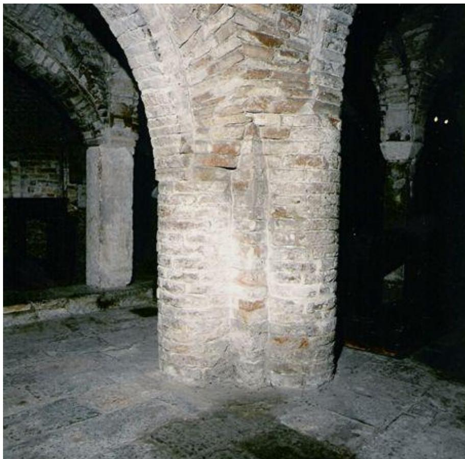
Fig. 16 – Anche i lobi di questo secondo pilastro (4 in fig. 7) hanno, come mostra la foto e come è evidenziato in fig. 17, diverse altezze da terra. Anche qui è evidente che gli archi delle volticciole poggiano direttamente sui pilastri (foto Ferrieri).
